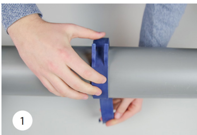
1. Monter Hydra Pipe Strap rundt røret
